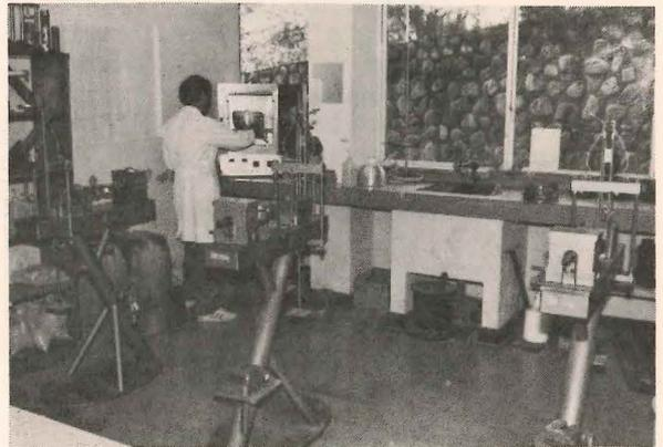
Laboratorio de Geotecnia. Se observan entre otros, diversos aparatos para ensayos físico-mecánicos: corte directo (cizallamiento) para ensayos drenados, no drenados y consolidados de suelos.
